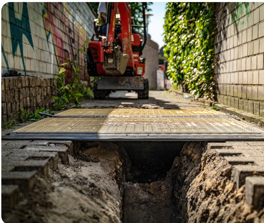
La plaque de franchissement permet le passage d'un véhicule au-dessus de tranchées d'une largeur maximale de 900 mm.
